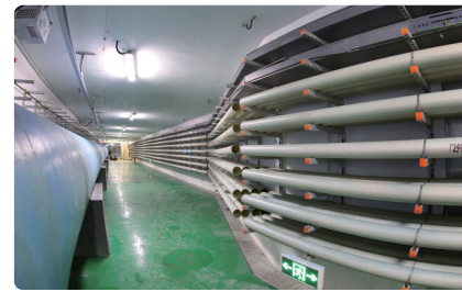
肇庆新区城市综合管廊内部结构图
