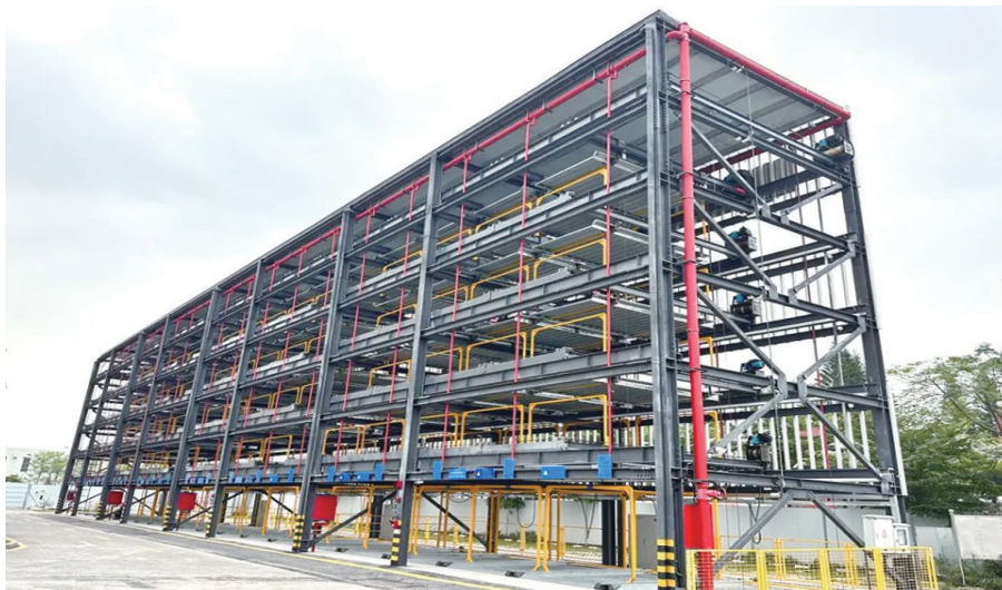
位于深圳宝安燕罗街道的机械式立体停车库（图源：宝安交通集团）
