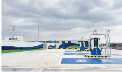
云韬氢能南香山服务区东区加氢站（广州市城管局供图）
