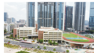
深圳人民路学校项目
