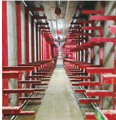
管廊主体（通讯员供图）
