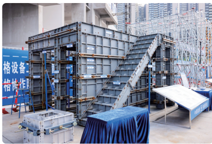
铝模建造工艺和施工要点展示
