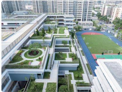
佛山市铁军小学东校区建设工程 (绿色屋顶)
