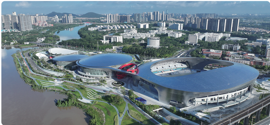
顺德区德胜体育中心工程
