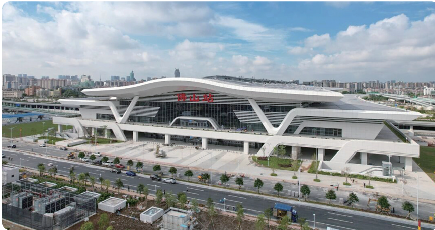
广湛高铁佛山站（图源：广州铁路）
