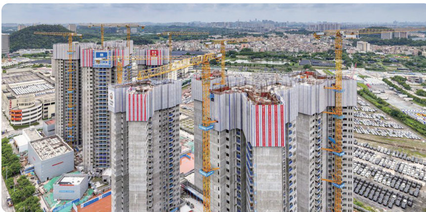
柏堂村城中村改造安置房主体结构封顶
