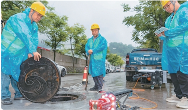
在湖北省宜昌市秭归县，技术人员正在操作管道检测机器人，为地下排水管网开展汛期“全身体检”。 彭强 摄（人民视觉）
