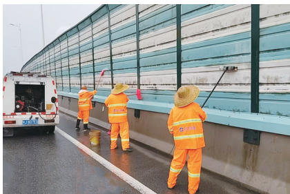
作业现场（通讯员供图）
