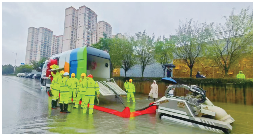
支援队伍在广西贵港市南广铁路桥底进行现场抢险作业(通讯员供图)
