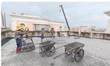
茂南区文明北路小区天面防水隔热改造施工现场
