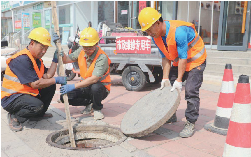
河北承德平泉市政维修处工作人员正在对易发生内涝的老城区主街排水管道疏通维护。李平文 摄
