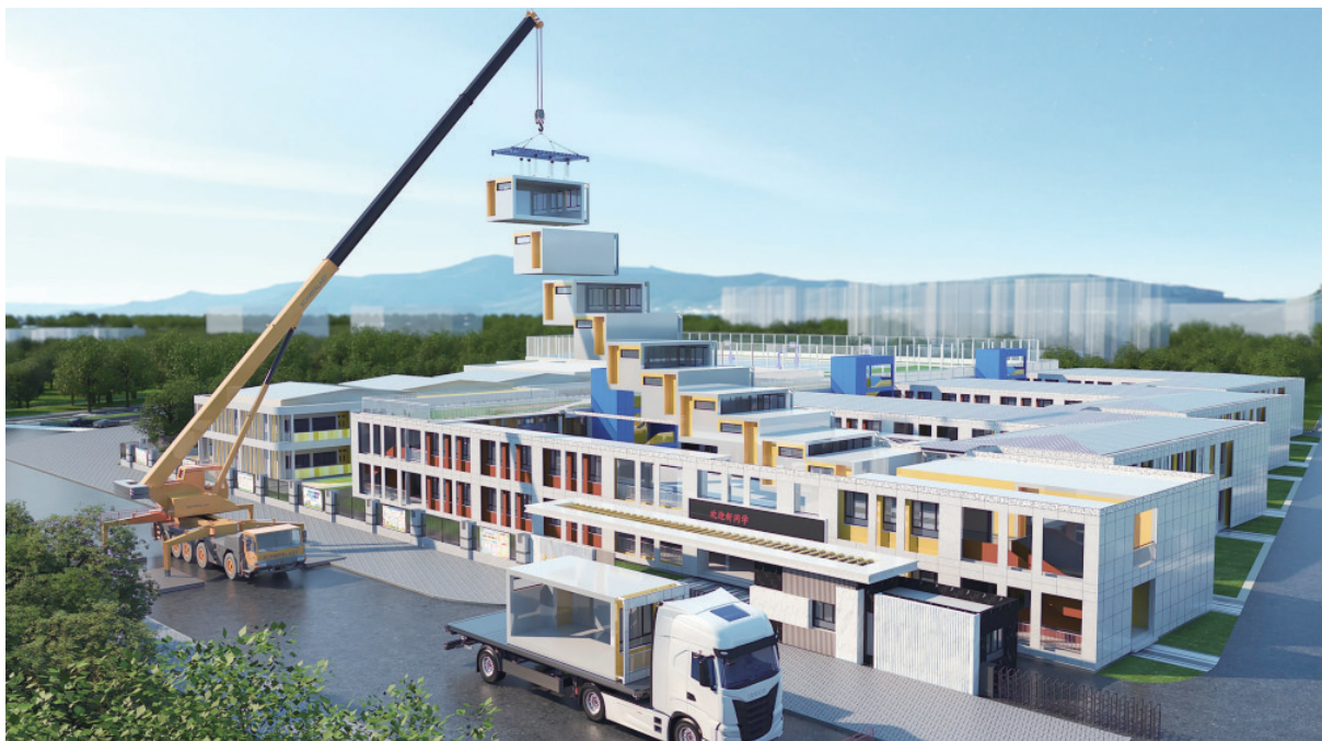
深圳市光明区实验学校同心小学搭建过程效果图，模块化快速建造缓解学位紧缺。（图源：中建海龙）
