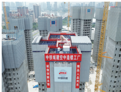
智能造楼机在南沙坦尾村更新改造项目中应用
