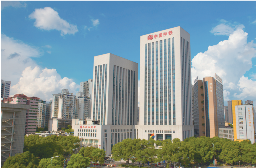
中铁五局长沙办公大楼
