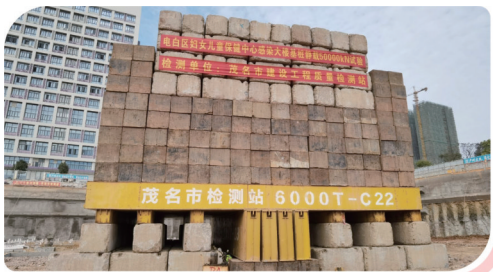
5000吨单桩竖向抗压静载试验
