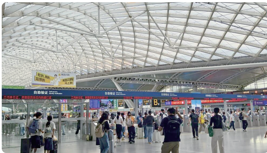
广州南站对三层候车大厅中央通廊进行了遮阳改造（图源：番禺政府网）
