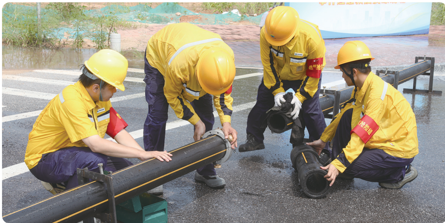
演练现场，工程技术人员对破损天然气管道进行抢修。
