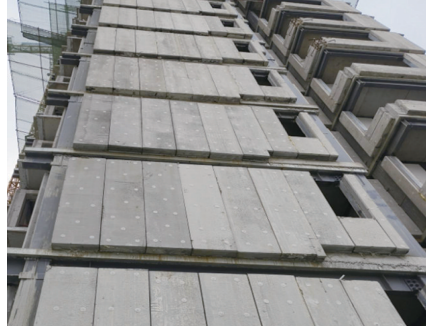
装配式外墙板接缝密封胶饱满，无渗漏工程实例。
