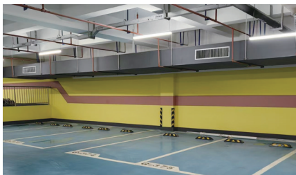
地下室侧墙无渗漏，油漆面光滑无起皮、脱落工程实例。
