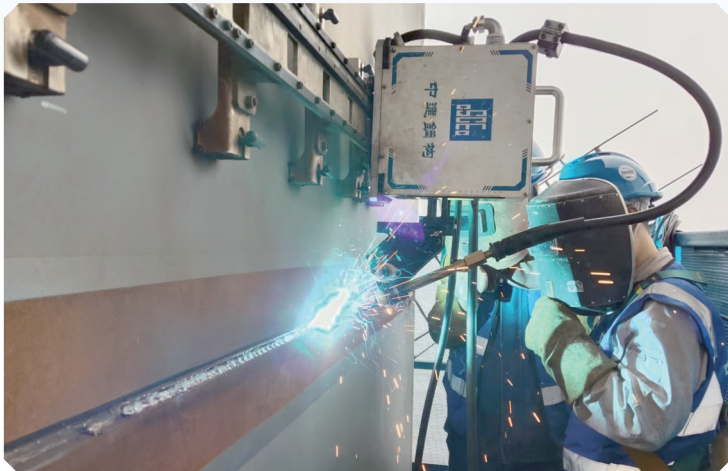
工人在操作钢构焊接机器人（图源：中建科工）
