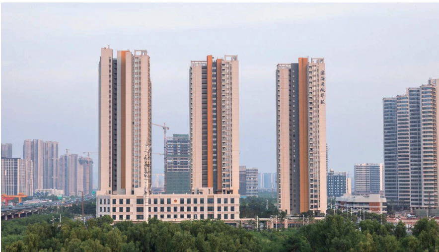
东莞滨海湾风华苑人才安居房（图源：“东莞滨海湾新区”微信公众号）
