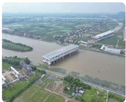
施工现场（图源：广东交通）
