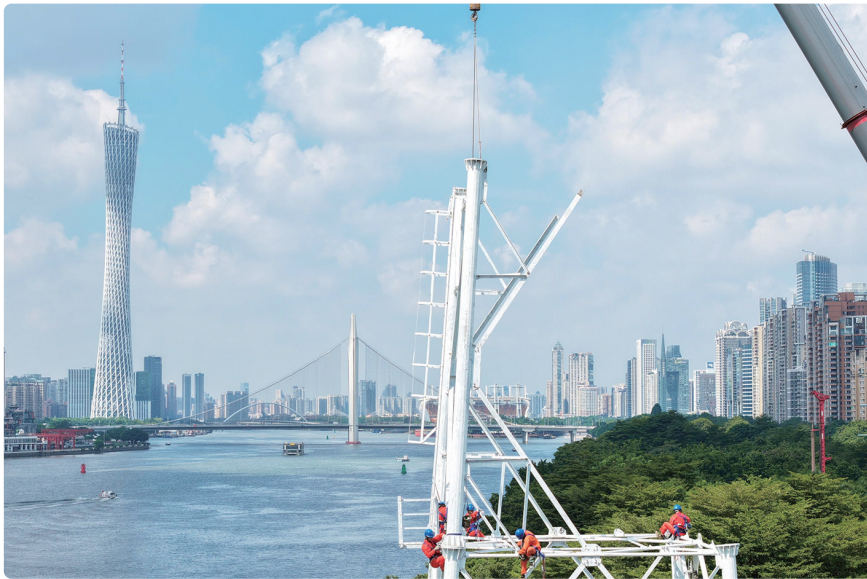
铁塔拆除现场（通讯员供图）
