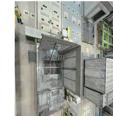
2026年8月16日，中建海龙位于深圳龙岗的智能建造生产线正在进行模块生产。新华社记者王优玲 摄
