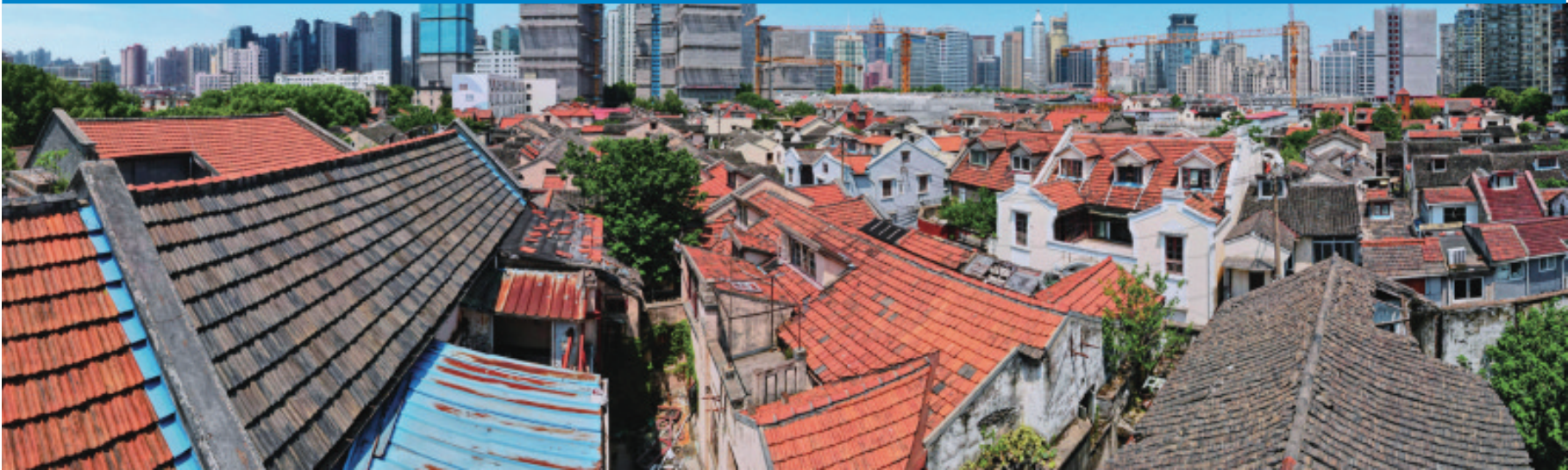
上海黄浦区508-514街坊地块旧城区改造一期项目建设中的楼房 方喆 摄
