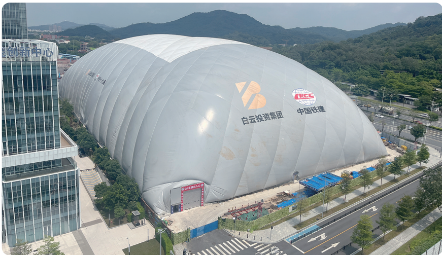
白云展览中心项目基坑气膜（通讯员供图）
