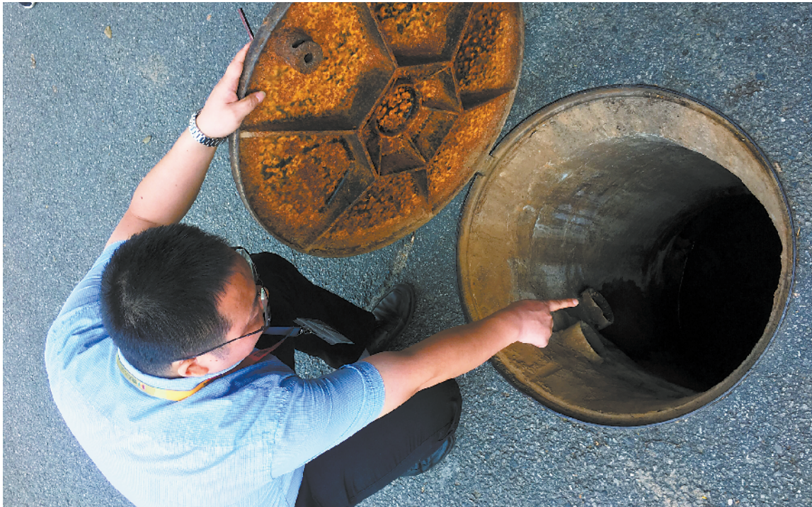
■在广州市恒远彩印有限公司,检查人员发现,雨水井中原有污水管已被截断,管网孔用水泥封堵起来。 新快报记者 蒋翰林/摄
