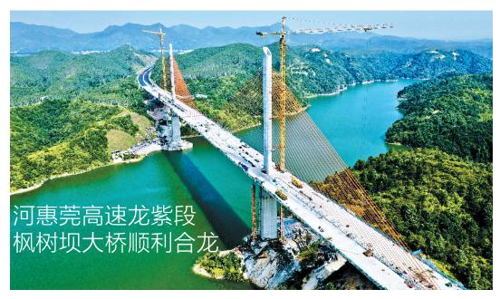
新快报讯 记者许力夫 通讯 员粤交集宣报道 昨天,随着最后 一方混凝土浇筑完成,河(源)惠 (州)(东)莞高速公路龙川至紫金 段控制性工程枫树坝大桥中跨顺 利合龙,标志着河惠莞高速龙紫 段主线全线贯通,项目具备 2019 年底通车条件。
