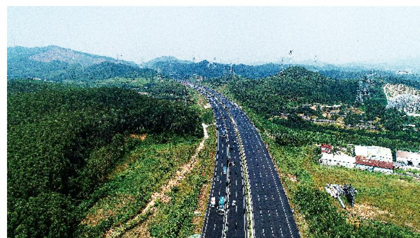
路水口立交相接,全长33.264公里,采用高速公路技术标准建设,为4车道扩8车道的改扩建工程。
