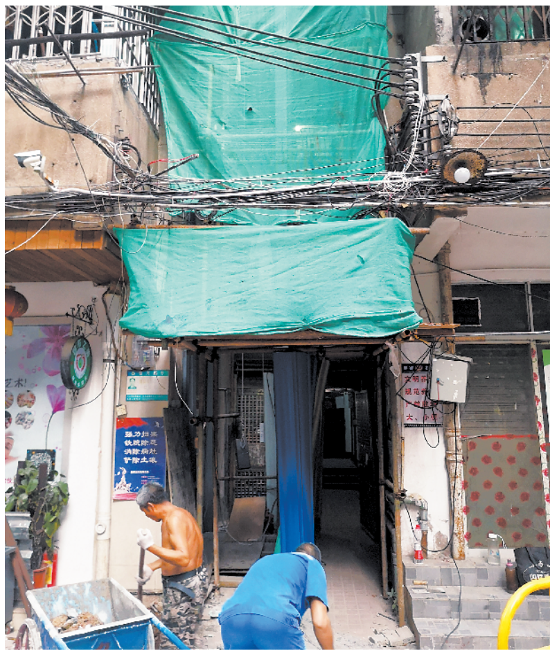
■电梯施工目前仍在进行。
