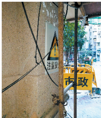
■大楼内侧能看到“突出的柱子”。
