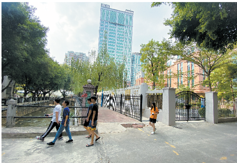
■记者在现场看到,现在河道约有6米宽,原来临河的铁围栏向后迁移并修筑成广州碧道科普墙。
