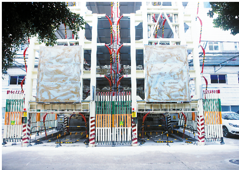
■天河区黄埔大道西一立体停车场至今仍未投入使用。
