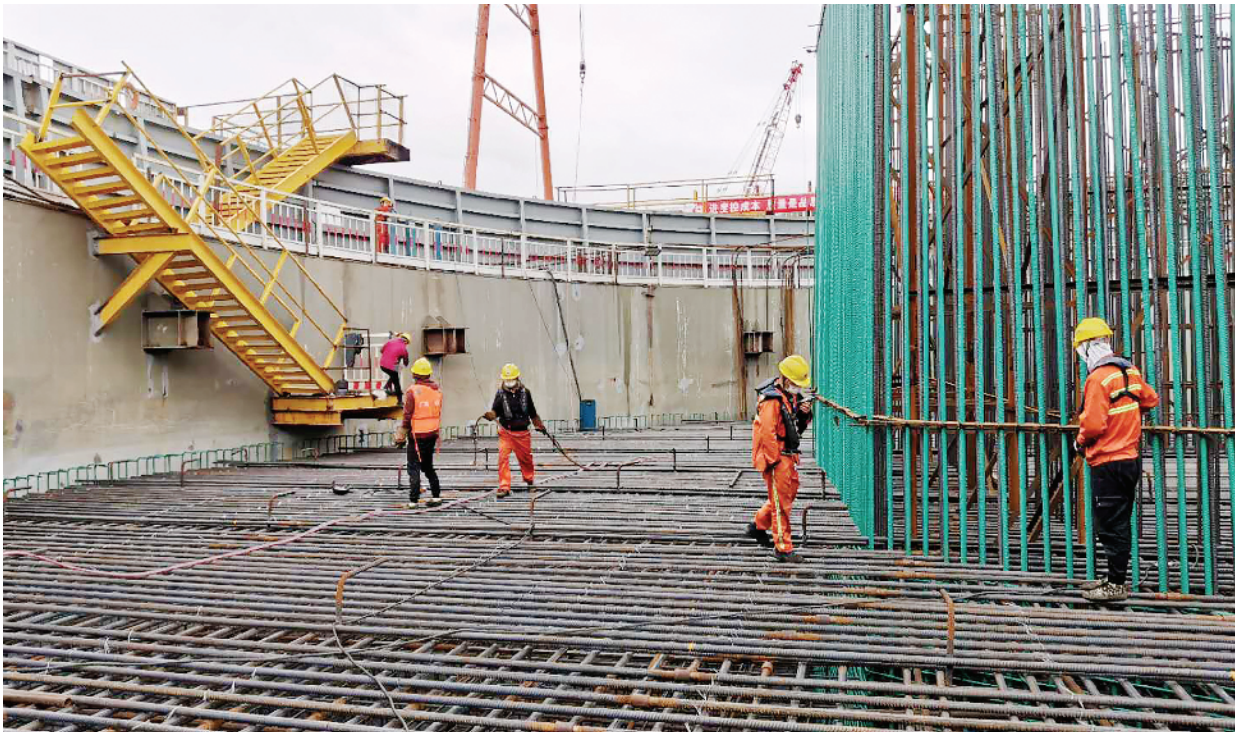
■施工人员在深中通道伶仃洋大桥西主墩承台作业(2月17日摄)。新华社发
