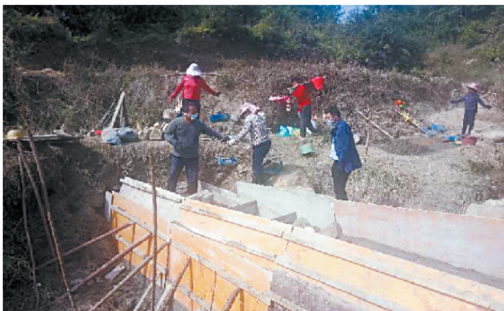
■被冲坏的农耕水渠开始修建了。
