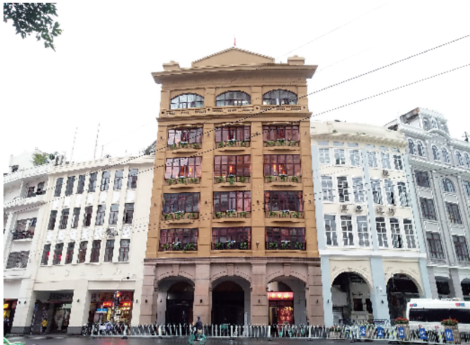
■北京路229号区登记保护文物保护单位改造后,立面上喷石漆,将窗门全拆了换成铝合金窗,全拆了铁艺,改变了原状。
