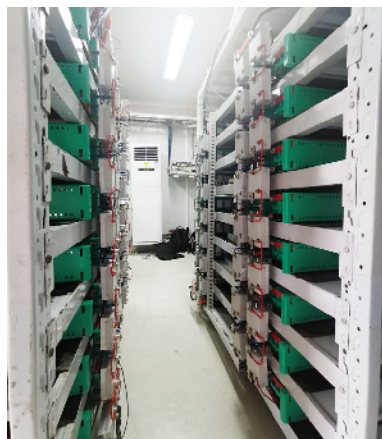
■位于白云区的通信基站备用电池储能示范项目。受访者供图
