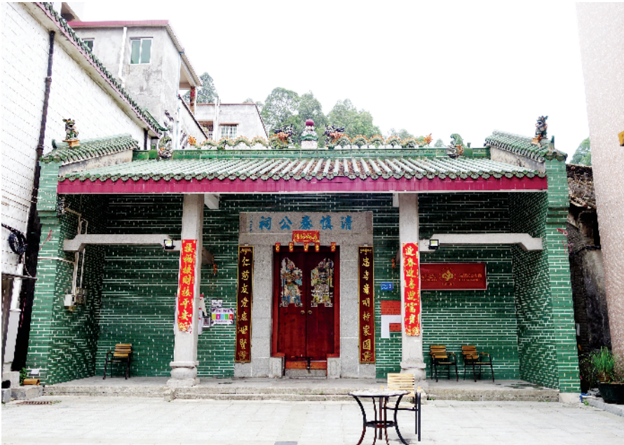
■清慎秦公祠重建于 1995 年,绿色的瓷片外墙、祠堂内白色的水泥墙和柱、钢筋混凝土结构,原状已彻底改变。
