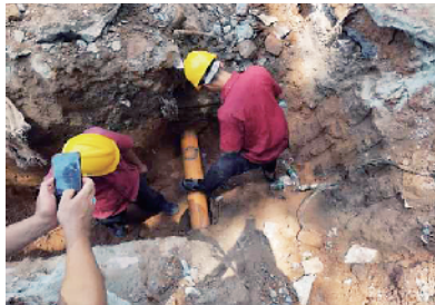
■广州市白云区一处燃气管道被钻穿漏气事故现场。 通讯员提供
