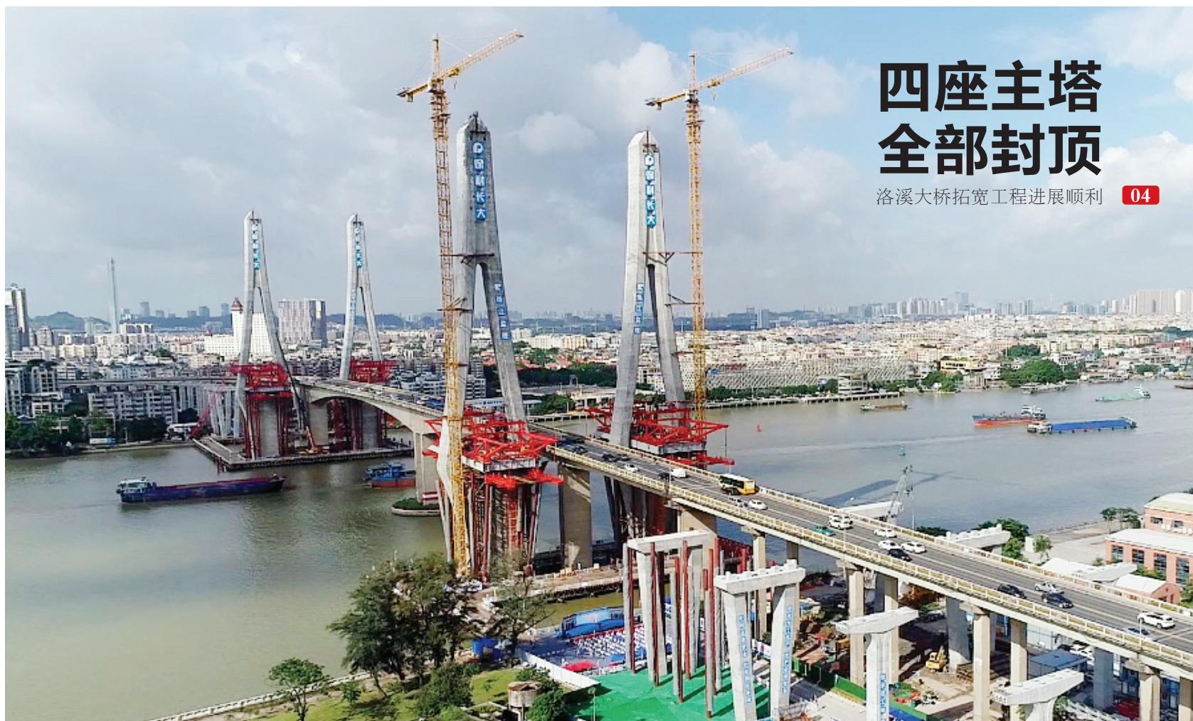
■目前,洛溪大桥新桥4个主塔已顺利封顶,无索区钢箱梁已顺利吊装,8台步履式桥面吊机正在安装,新桥预计年底通车。
