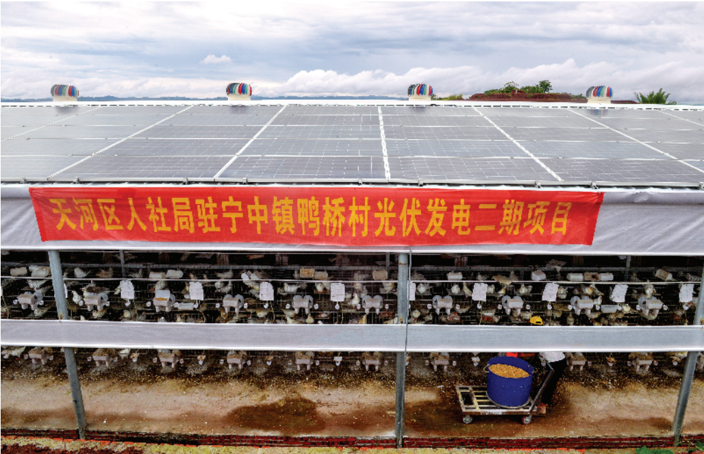
工作组积极协调金绿公司和兴宁市发改局等相关单位,并做通贫困村工作,通过鸽棚加固、改造变压器等措施,在棚顶成功架设光伏电板,创新建成农光互补产业。
