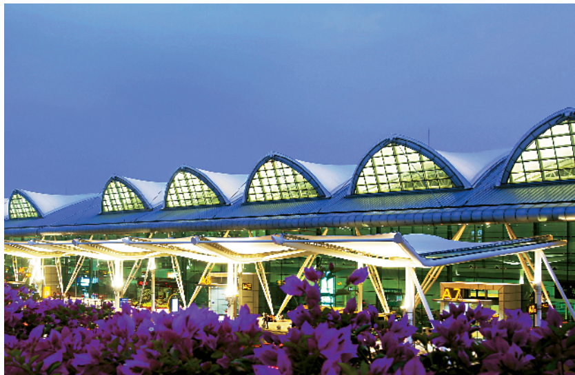
■广州白云国际机场的航站楼规划引入新的高铁、城际、地铁线路。 新快报记者 龚吉林/摄
