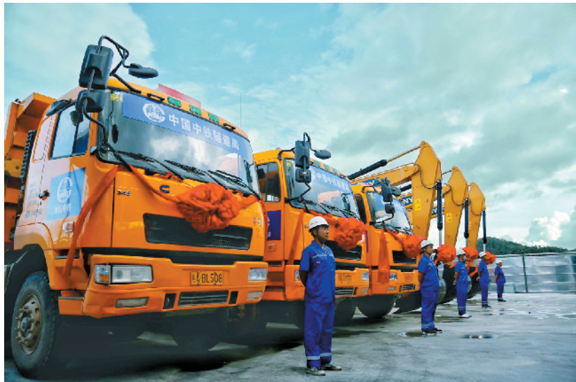
■深江铁路珠江口隧道正式开工建设。
