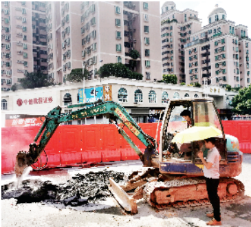
■施工人員正在用挖掘機對圍蔽區域內的路面開挖。 实习生 吴昊天/攝
