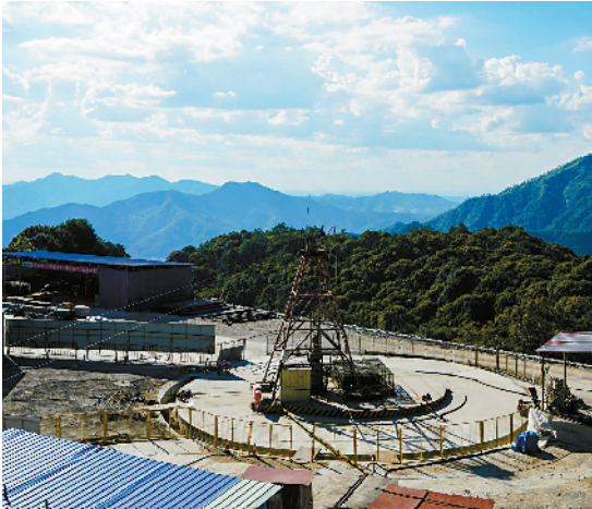
■竖井位于鸿图特长隧道右洞一侧,相当于在隧道内插一根“吸管”,向内部供给新鲜空气。通讯员供图
