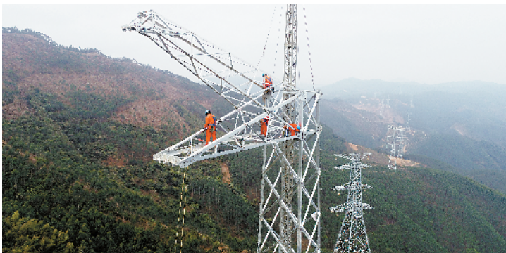
■昆柳龙直流工程广东受端交流配套工程惠州段,施工人员在山岭中进行输电杆塔的装配工作。(南方电网广东惠州供电局提供)
