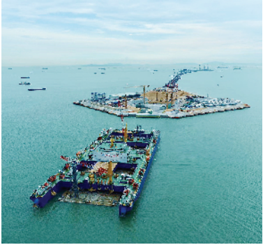
■昨天,深中通道沉管隧道 E2 管节完成沉放并顺利对接。 通讯员供图
