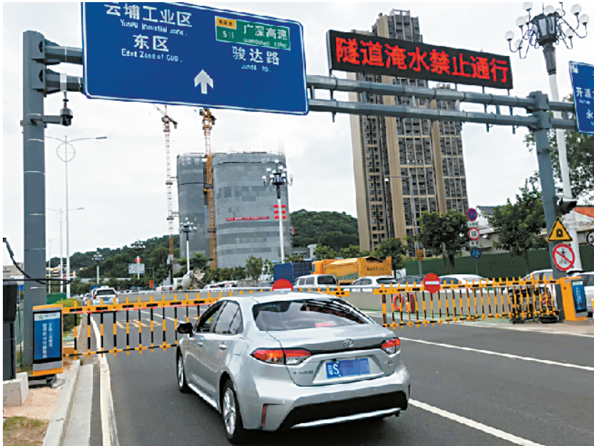
■在开源大道隧道,当水位淹没涉水线,道闸自动关闭,拦截双向车辆。新快报记者 何生廷/摄
