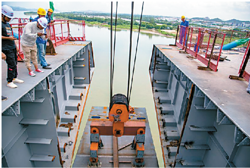
■南沙港铁路跨西江斜拉桥顺利合龙,它是目前世界双线货运铁路建设史上同类型结构跨度世界之最。 通讯员供图
